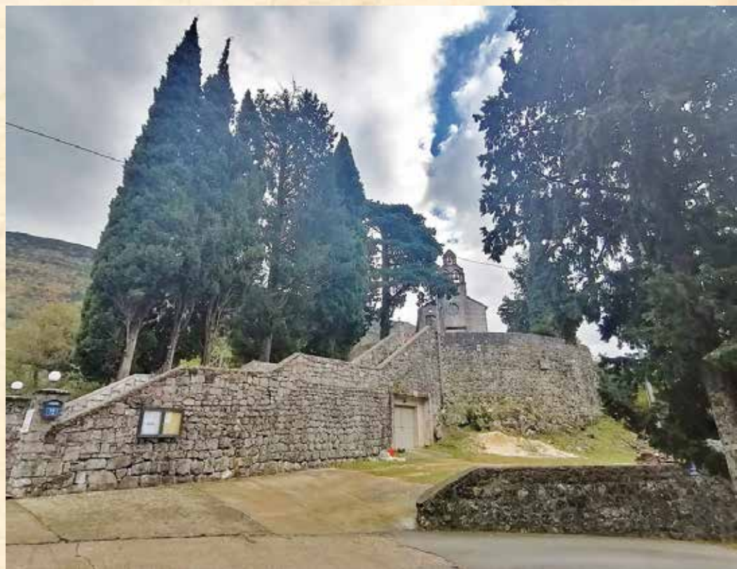
Crkva Sv. Petra na gradini
