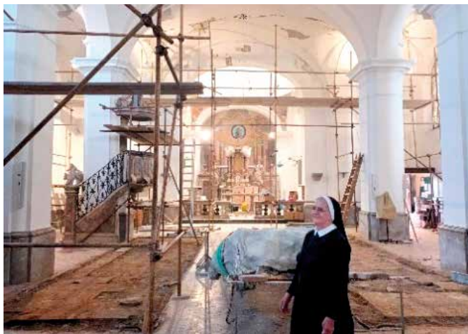
Crkva sv. Marije na Dolcu u obnovi
